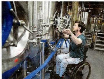
Brouwer Daniël de Vlas kan vanuit zijn rolstoel bij de ketels die voor hem op goede hoogte zijn geplaatst.
